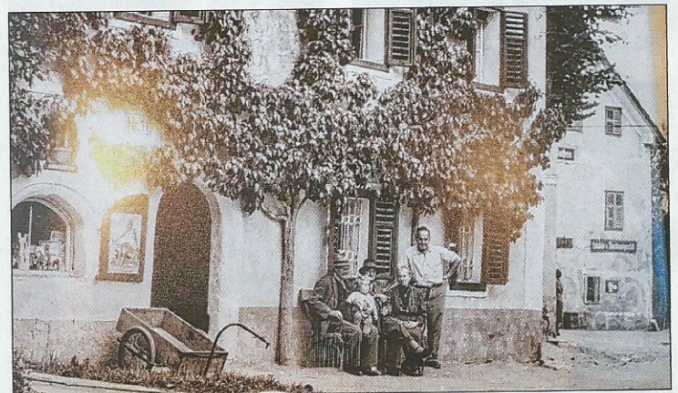
„Flexible Öffnungszeiten“ bei der einstigen Goiserer Seifensiederei: Standen die Läden beim Fenster (links) offen, war das Geschäft geöffnet.
